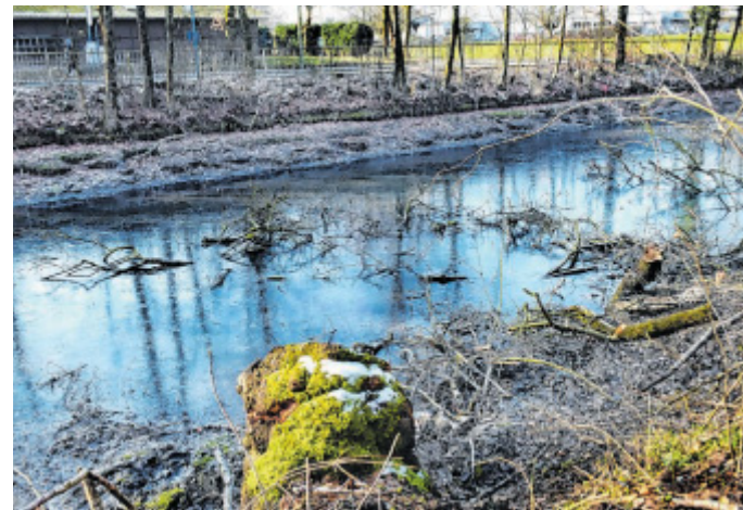
Voller Äste: Das Regenrückhaltebecken Meyerbach an der Potsdamer Straße. Das sah schon vor Sturm „Friederike“ so aus.
